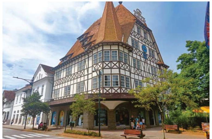
In Blumenau in Brasilien im Bundesstaat Santa Catarina, versprühen die vielen, meist nachgebauten Fachwerkhäuser eine Atmosphäre der deutschen Kolonialzeit um 1850.
